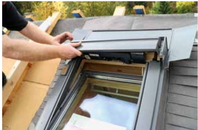
Der Eindeckrahmen sorgt mitsamt der Anschlusschürze für einen regen- und schneesicheren Abschluss.
